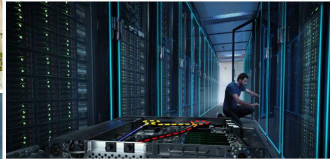
Skříň datového serveru přímo chlazená kapalinou
